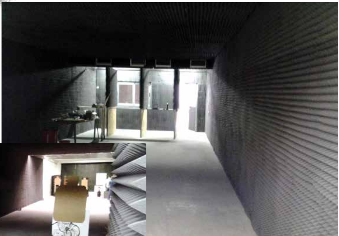
Applicazione di Mappysil piramidale AU Poligono di tiro - Orio al Serio
